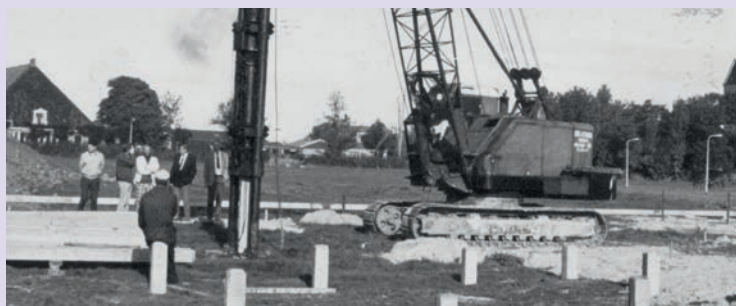
12-09-1986: start bouw de Gearhing
