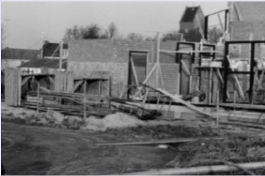
Bouw MFC de Gearhing
