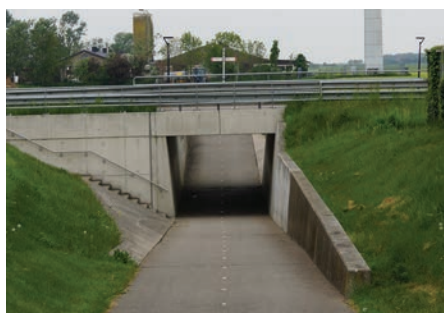
De fietstunnel onder de N359. Links de trap naar de bushalte
