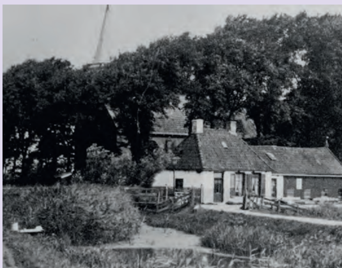
Hieslum: De vaart met bruggetje is vervangen door de huidige parkeerplaats
